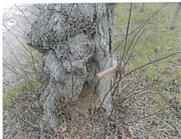
Photographies n°6 et n°7: Ci dessus: cavité à la base du tilleul n°24.
